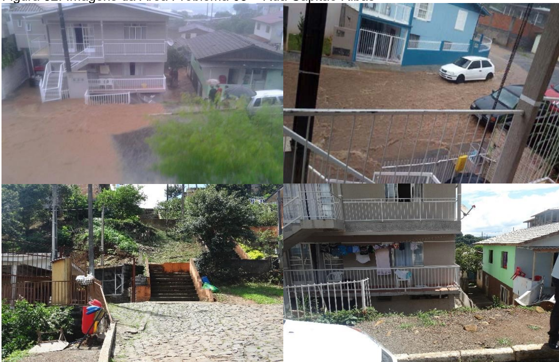
Figura 52: Imagens da Área Problema 05 – Rua Capitão Ribas
